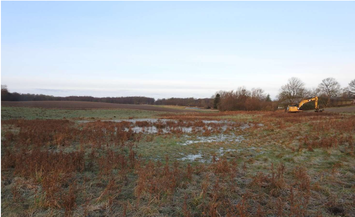
Opstart på gravearbejdet med en ny sø ved Kragevig (O11) 9 i december 2019.
